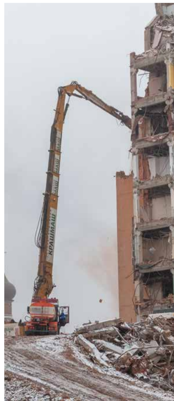
При производстве работ использовался экскаватор CAT-390
